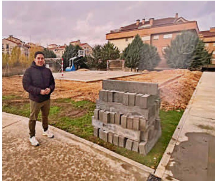
El edil Jorge Valiente en la obra de mejora de la instalación deportiva. EÑE
