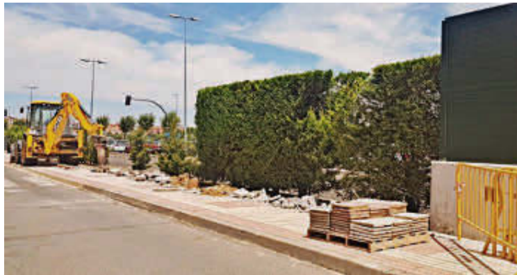
La obra de instalación de la nueva pantalla acústica en La Fontana. | EÑE
