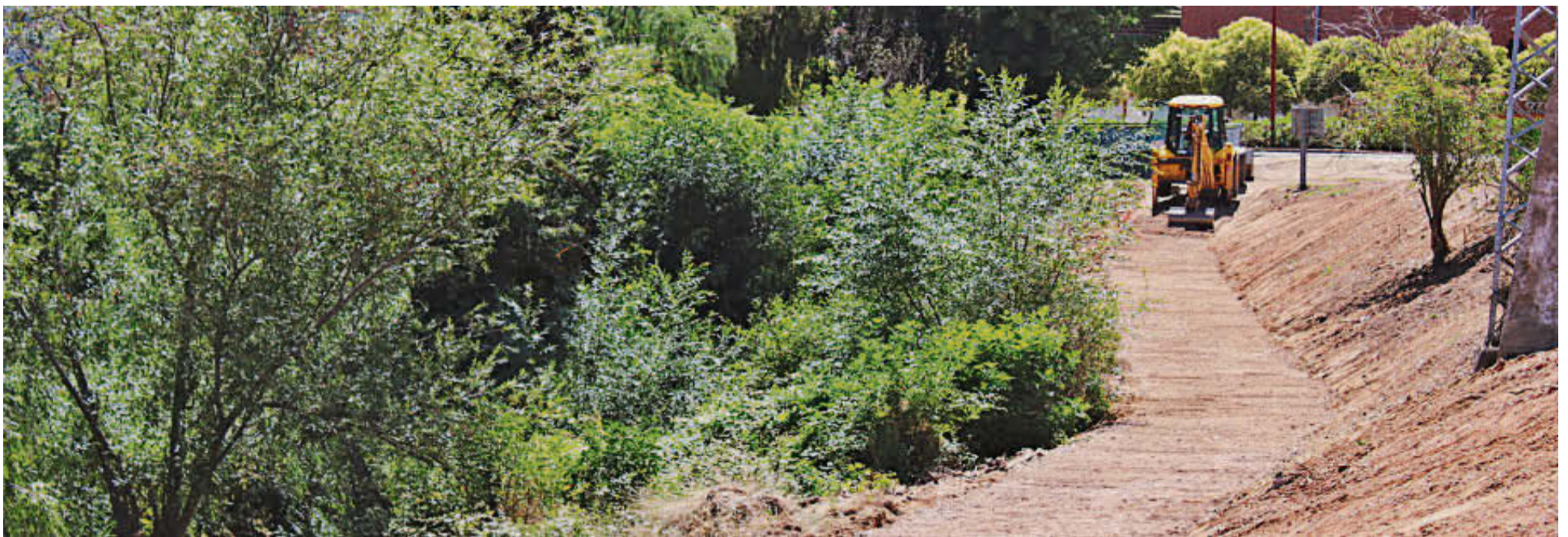
Operarios trabajan en las tareas de acondicionamiento del nuevo paseo fluvial de Santa Marta de Tormes que unirá la trasera de El Paraíso con La Fontana. | EÑE
