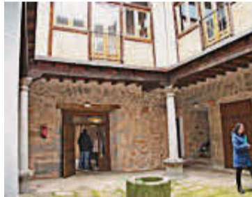
El patio del histórico edificio.
