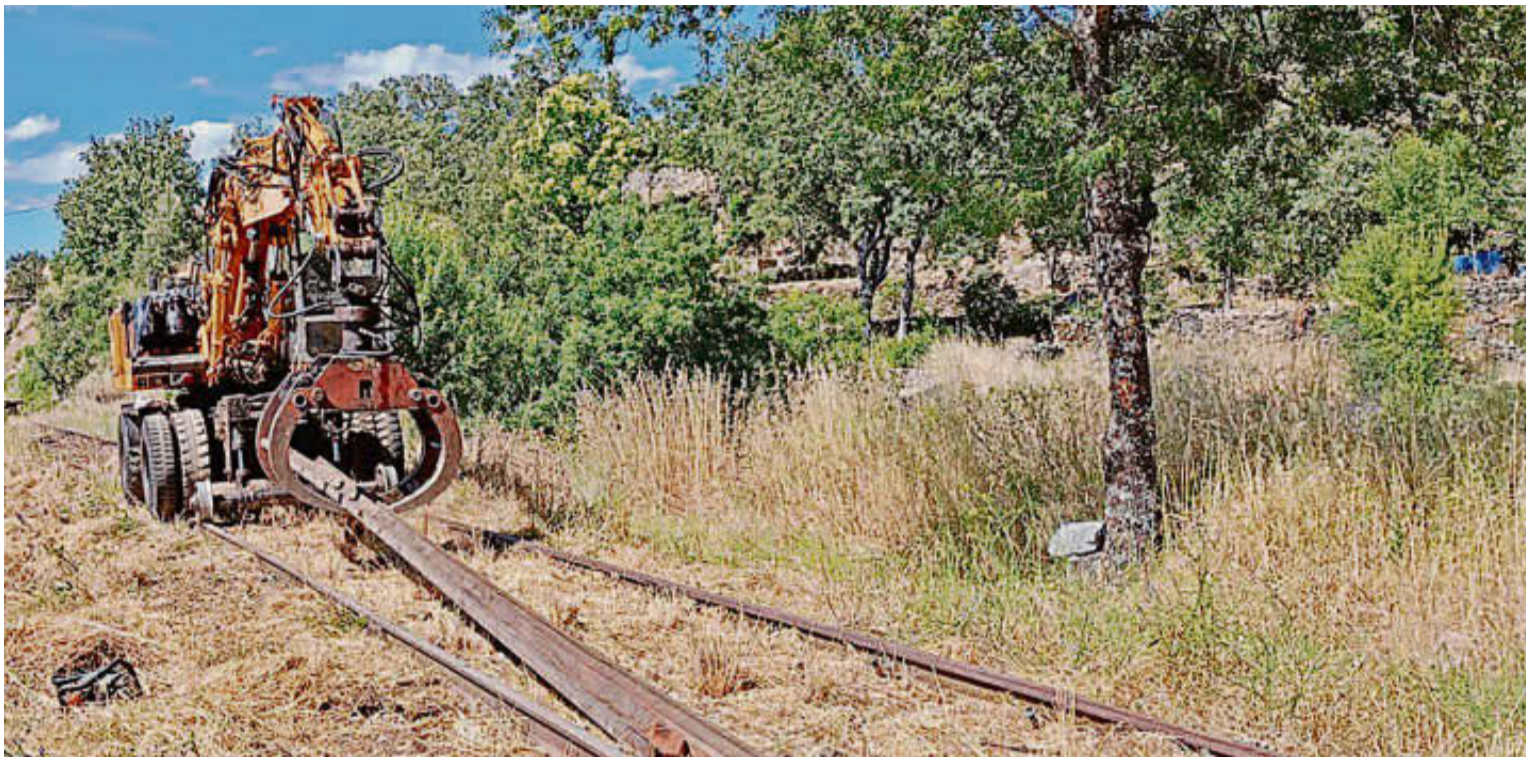
Imagen de las labores de levantamiento de las vías del tren a la altura de la localidad de Navalморal de Béjar. TEL
