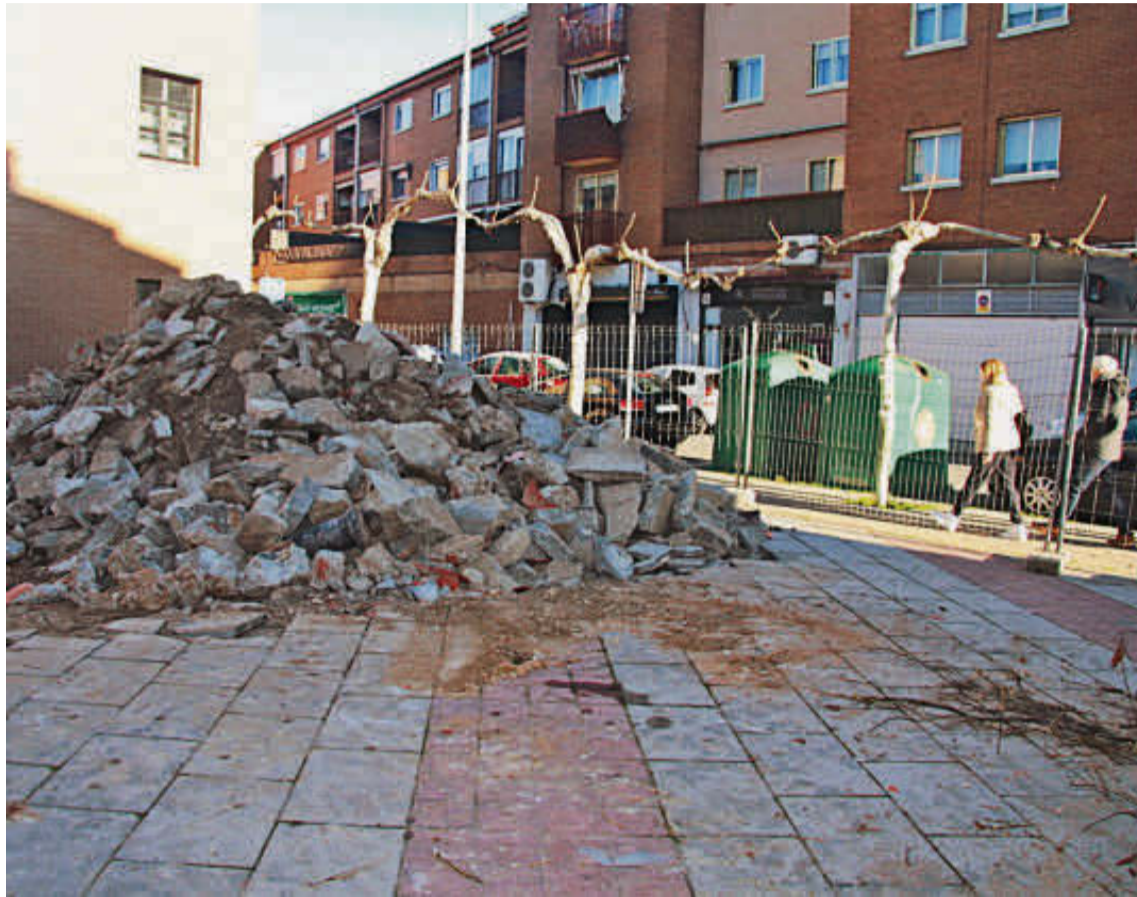
El inicio de las obras de ampliación del centro de salud de Santa Marta. EÑE
