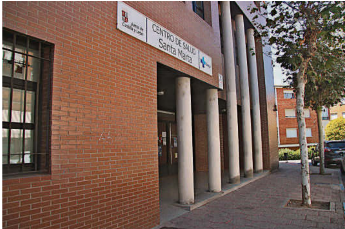
Entrada principal del centro de salud de Santa Marta, situado en la calle Padre Ignacio Ellacuría. EÑE
