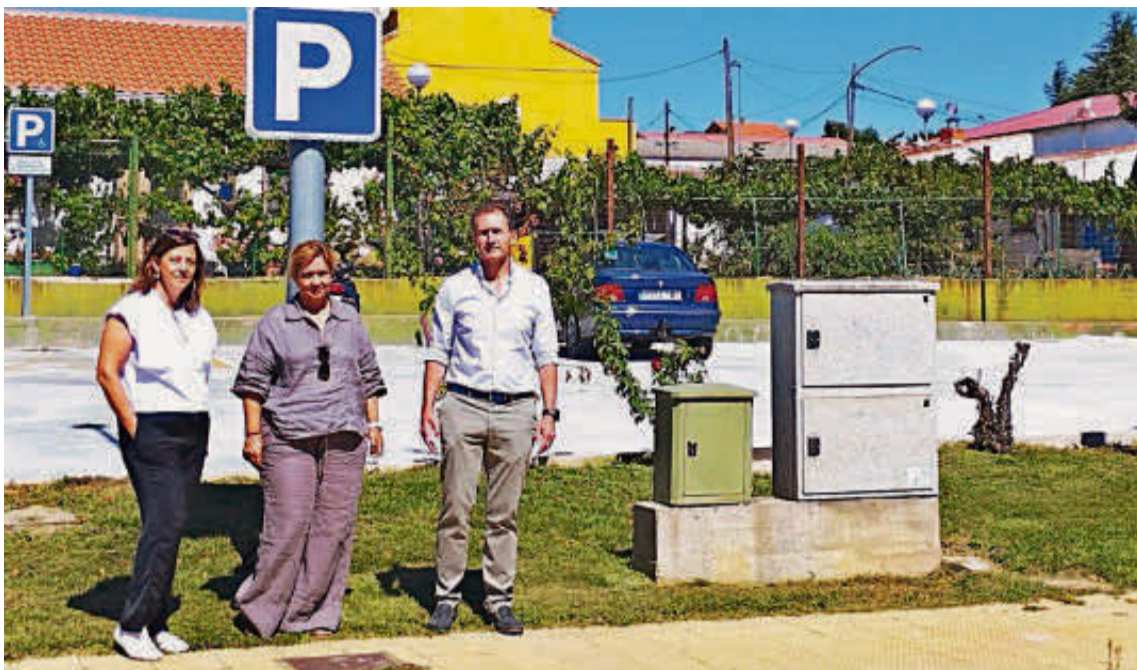
Patricia López, Soraya San Juan y Enrique García en la nueva infraestructura municipal de Aldeatejada. EÑE
