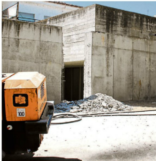
Las obras para mejorar la accesibilidad de la Escuela de Hostelería /EÑE
