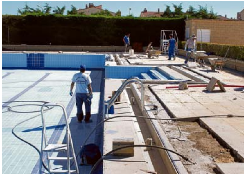
Los trabajadores se afanan en ultimar las obras y los remates en los rebosaderos y losetas del suelo./EÑE
