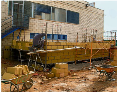
Las obras de los nuevos vestuarios de la piscina climatizada./EÑE
