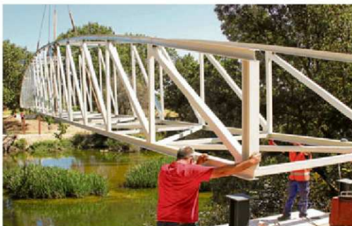
Las tareas de instalación de la nueva pasarela peatonal de acceso a la isla.
