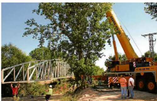
Una grúa de gran tonelaje colocó la pasarela de 70 metros de largo./FOTOS: EÑE
