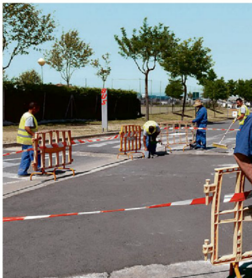
Los nuevos operarios temporales ya están realizando obras en el municipio./EÑE
