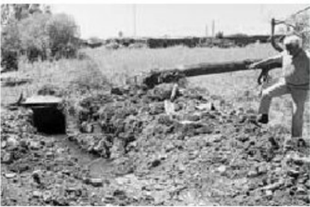
Los trabajos de saneamiento ya han comenzado./EÑE
