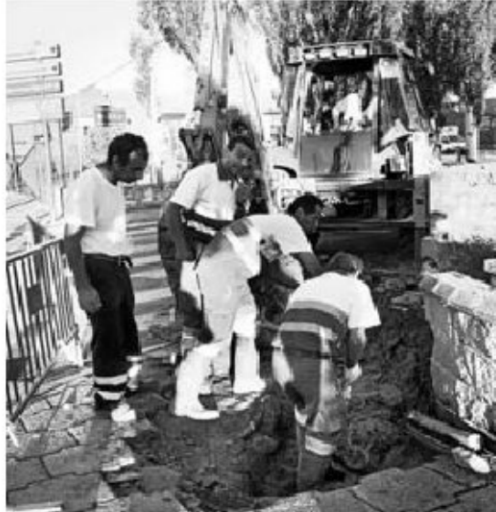
Los técnicos de Aqualia iniciaron los trabajos de inmediato. /EÑE
