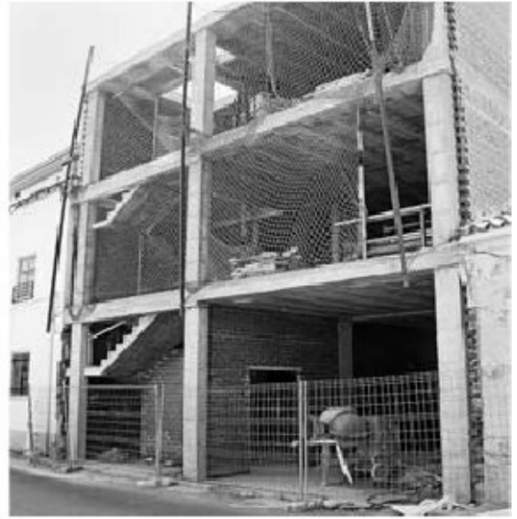
La estructura del nuevo edificio está concluida, a falta del cerramiento./EÑE
